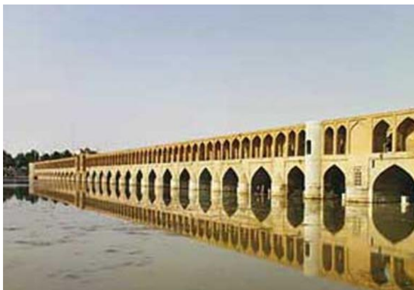
تصویر شماره ۱۰: سی‌وسه پل
