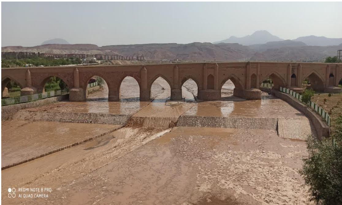
تصویر شماره ۱۱: نمایی از پل آجی چای از ضلع غربی
